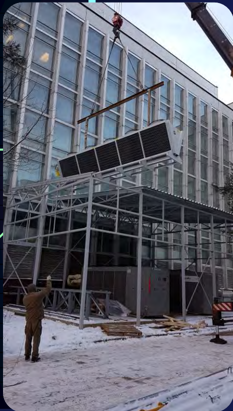
Установка сухой градирни
