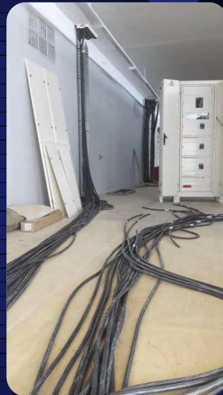
Подготовка линий электропитания суперкомпьютера
