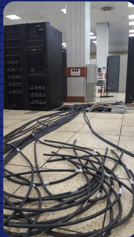
Подготовка линий электропитания суперкомпьютера
